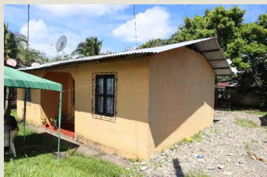
Figura 13. Vista externa de la casa CBSW.
