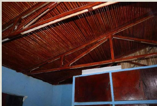
Figura 15. Vista interna de la casa CBSW: observe el techo de caña de bambú dividida.
