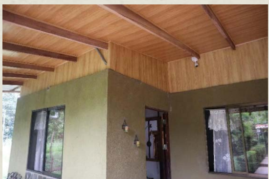
Figura 12. Vista externa de la casa CBSW.
