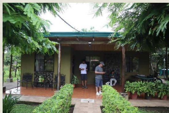
Figura 11. Vista externa de la casa CBSW.
