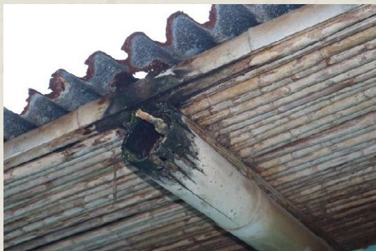
Figura 22. Caña de bambú podrido donde estuvo expuesto a la lluvia.
