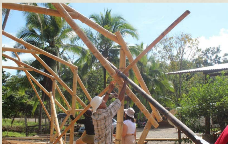
Figura 4. Construcción de un secador de bambú, Península de Osa. Fotografía: PROBAMBÚ, Michael Córdoba Alvarado, 2023.
