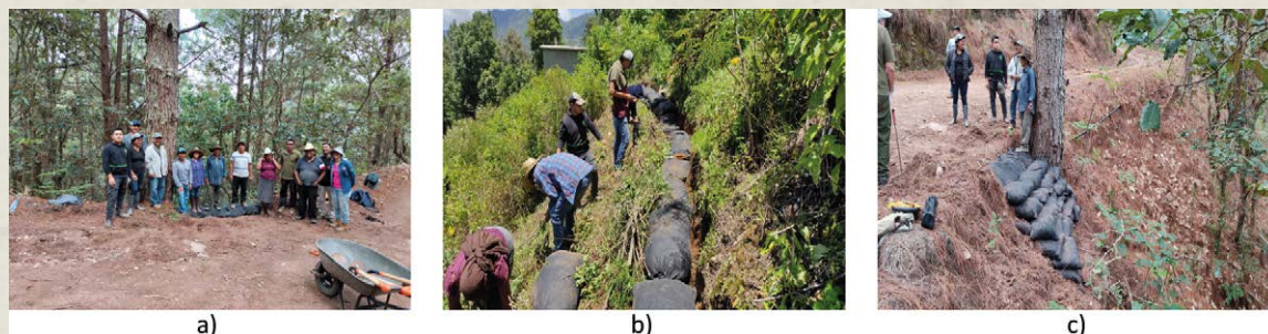
Figura 6. Implementación de unidades CONSABIO. a) Grupo de trabajo; b) Difusores; c) Estabilidad de escurrimiento con geocostales.
