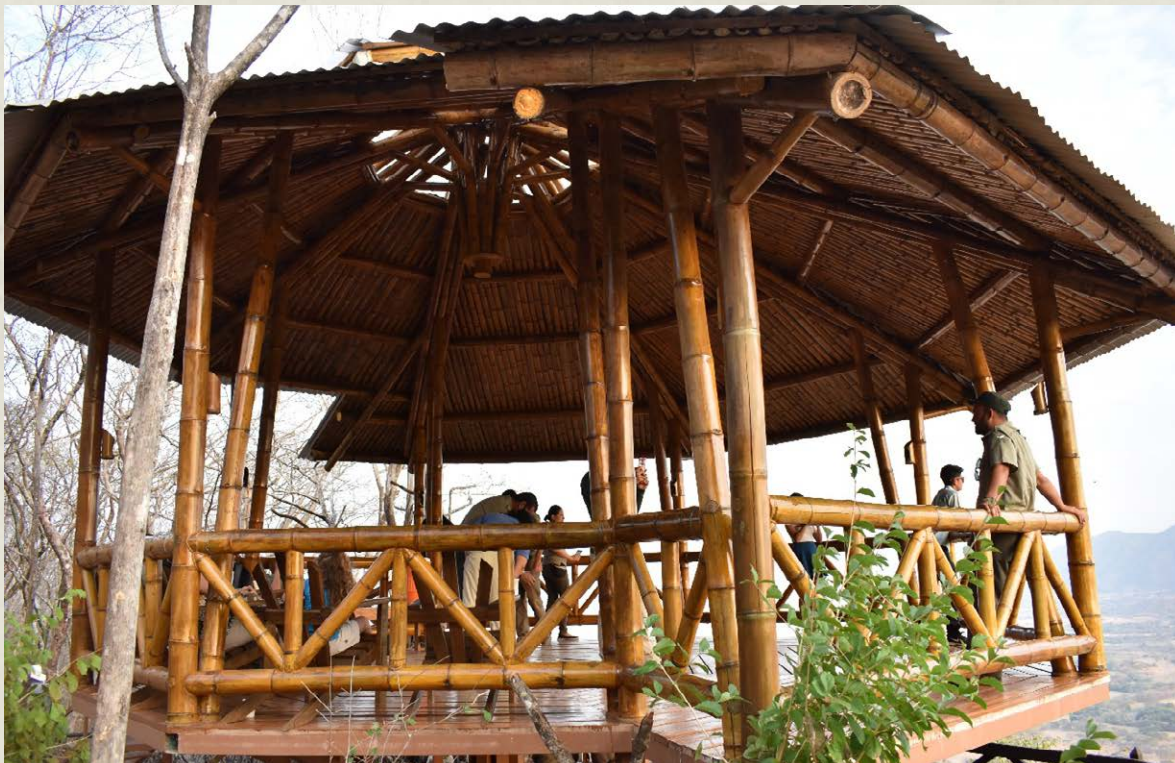
Construcción con bambú del mirador Nacaome, Parque Nacional Barra Honda (Fotografía: Marco Vinicio Varela Miranda)
