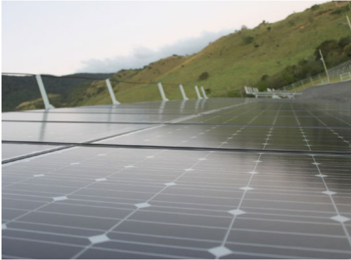
Parque Solar Miravalles del Instituto Costarricense de Electricidad. Fotografía: Sergio Molina.
