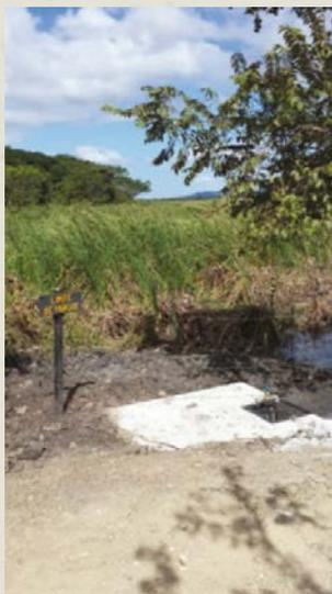
**Figura 5.** Toma de agua para suplir vehículos extintores de agua en caso de incendios en el sector Catalinas, PNPV. Fotografía: Wilfran Murillo.
