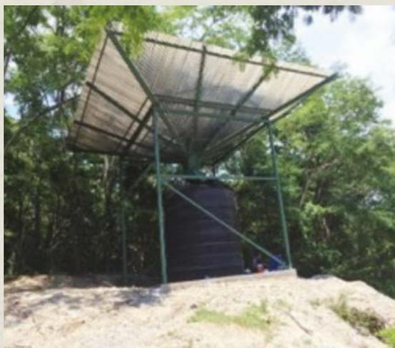
**Figura 6.** Tanque para la cosecha de agua (21 000 litros) instalado en sector Catalinas para la atención de incendios y proveer del líquido a la biodiversidad en época seca. Fotografía: Wilfran Murillo.
