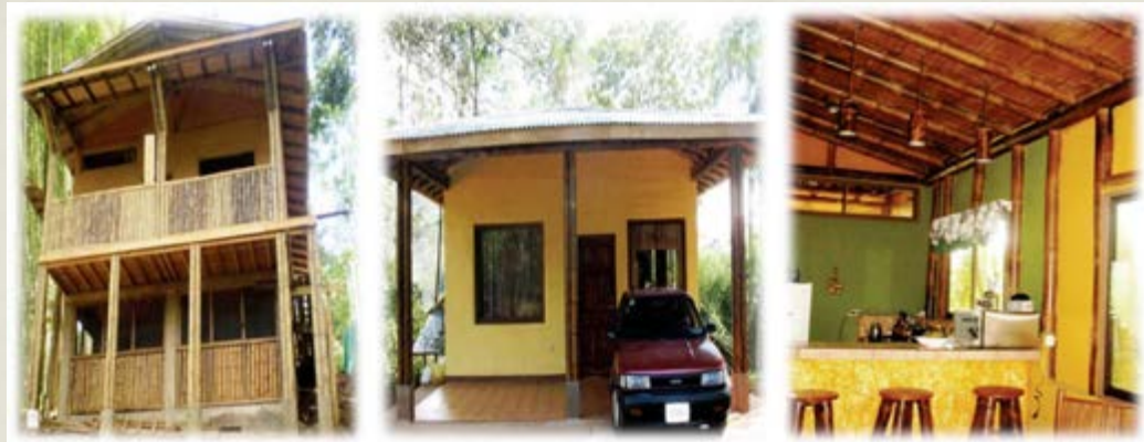
Figura 6. Casas construidas en Pérez Zeledón utilizando bambú
