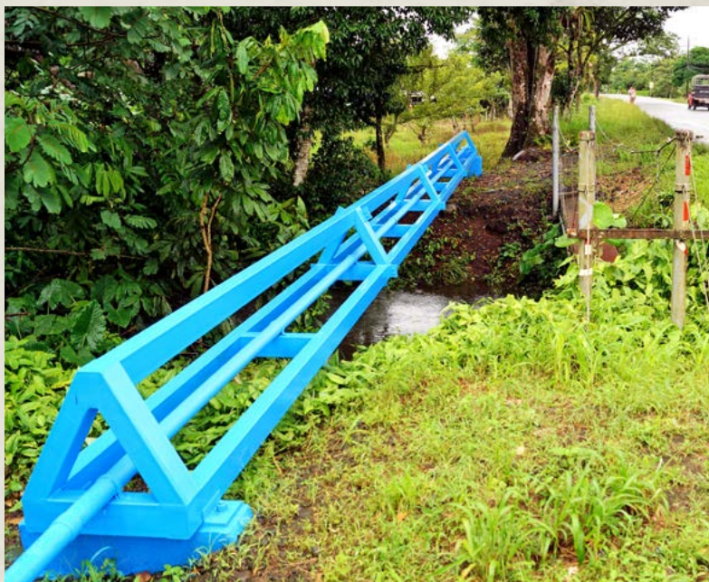
AyA. Acueducto ASADA Guatuso, Costa Rica.
