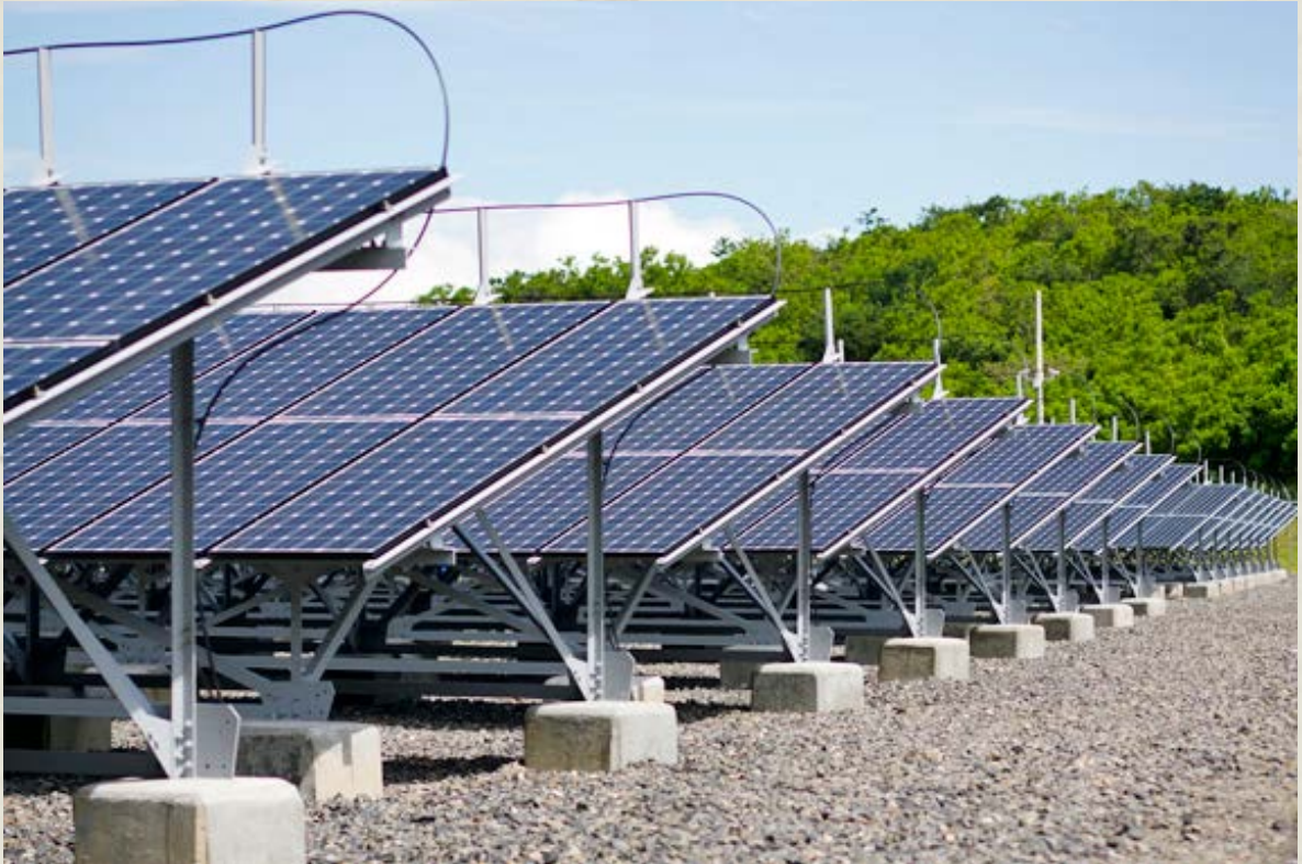
A. Baltodano. Planta Solar Miravalles, Costa Rica.
