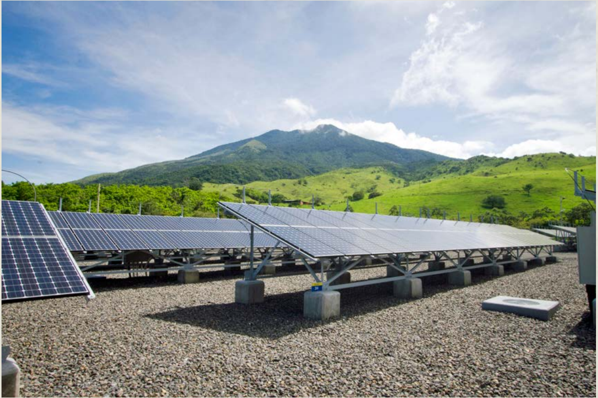
A. Baltodano. Planta Solar Miravalles, Costa Rica.
