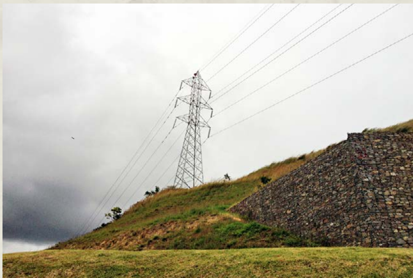
A. Baltodano. Tendido eléctrico, Costa Rica.
