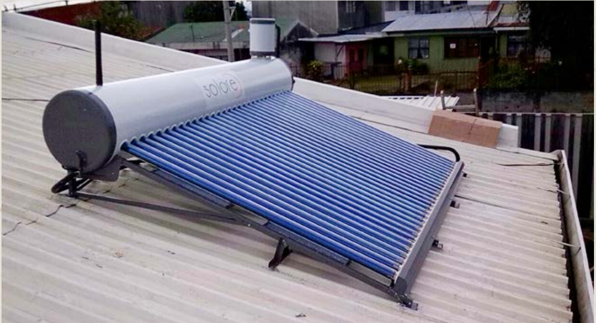
A. Baltodano. Paneles solares de Enertiva, Costa Rica.
