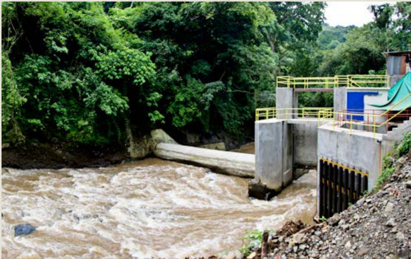
A. Baltodano. Proyecto Hidroeléctrico Tacares, Alajuela.
