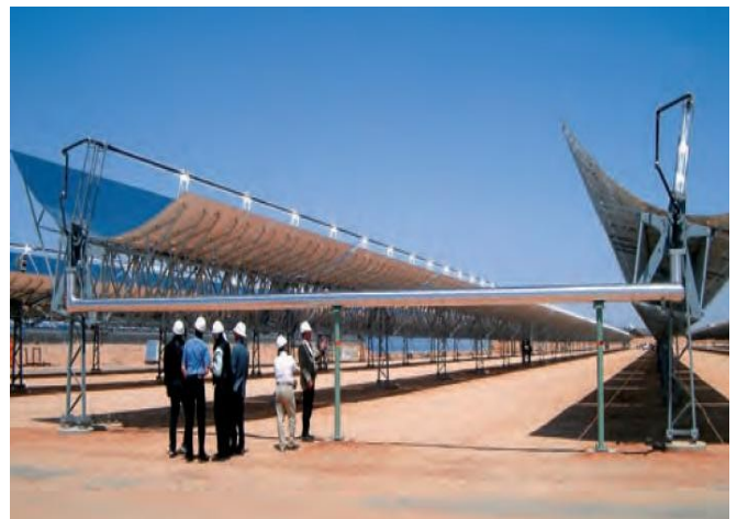
Planta solar para generar electricidad
