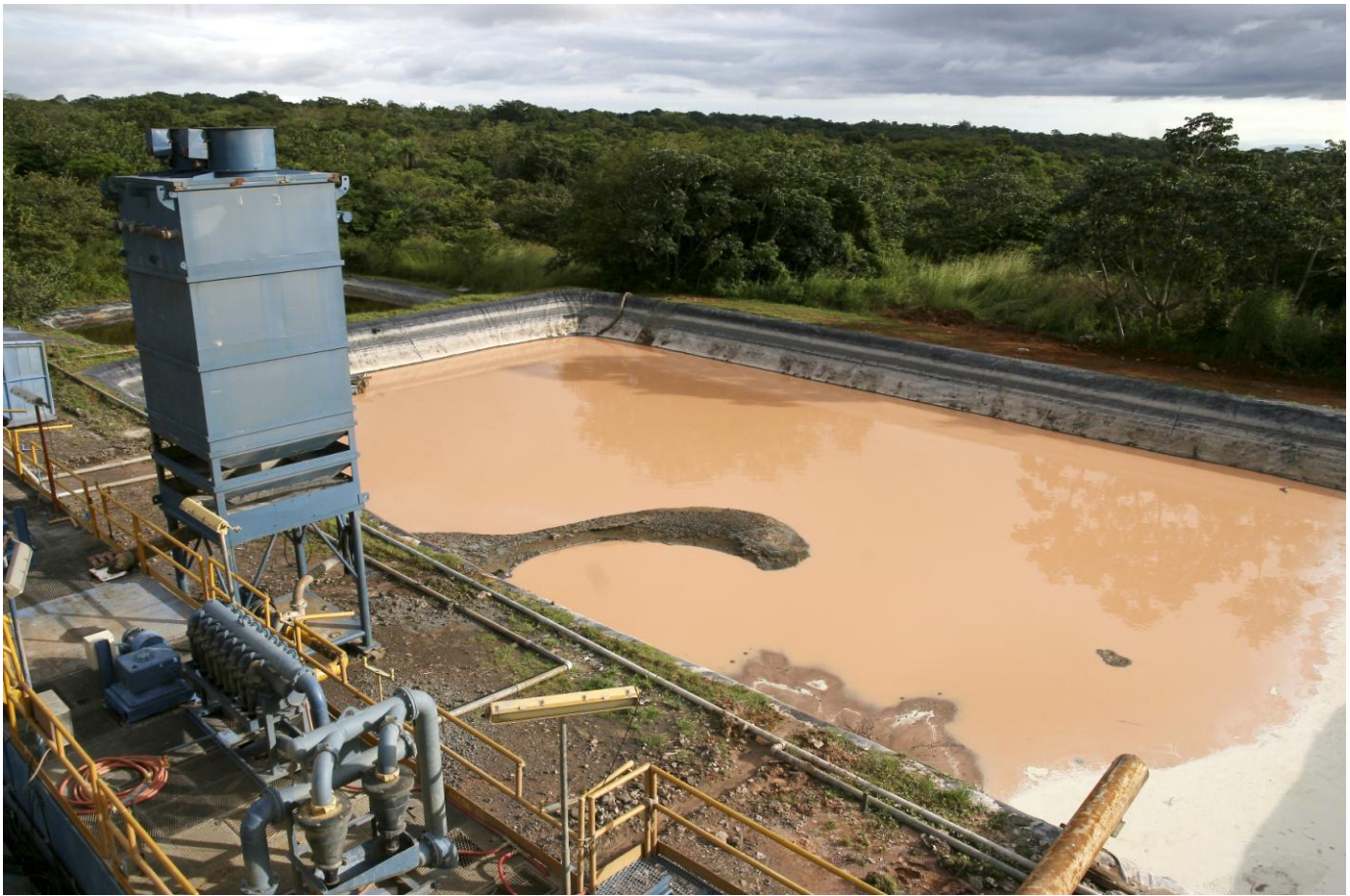
Tanque de lodos para perforación de pozos para el Proyecto Geotérmico Las Pailas, Rincón de la Vieja, Guanacaste
