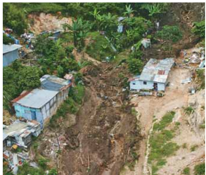
Deslizamiento en el Valle Central, Costa Rica
