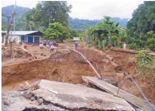
Estragos por desbordamiento de río en Quepos, Pacífico Sur, Costa Rica
