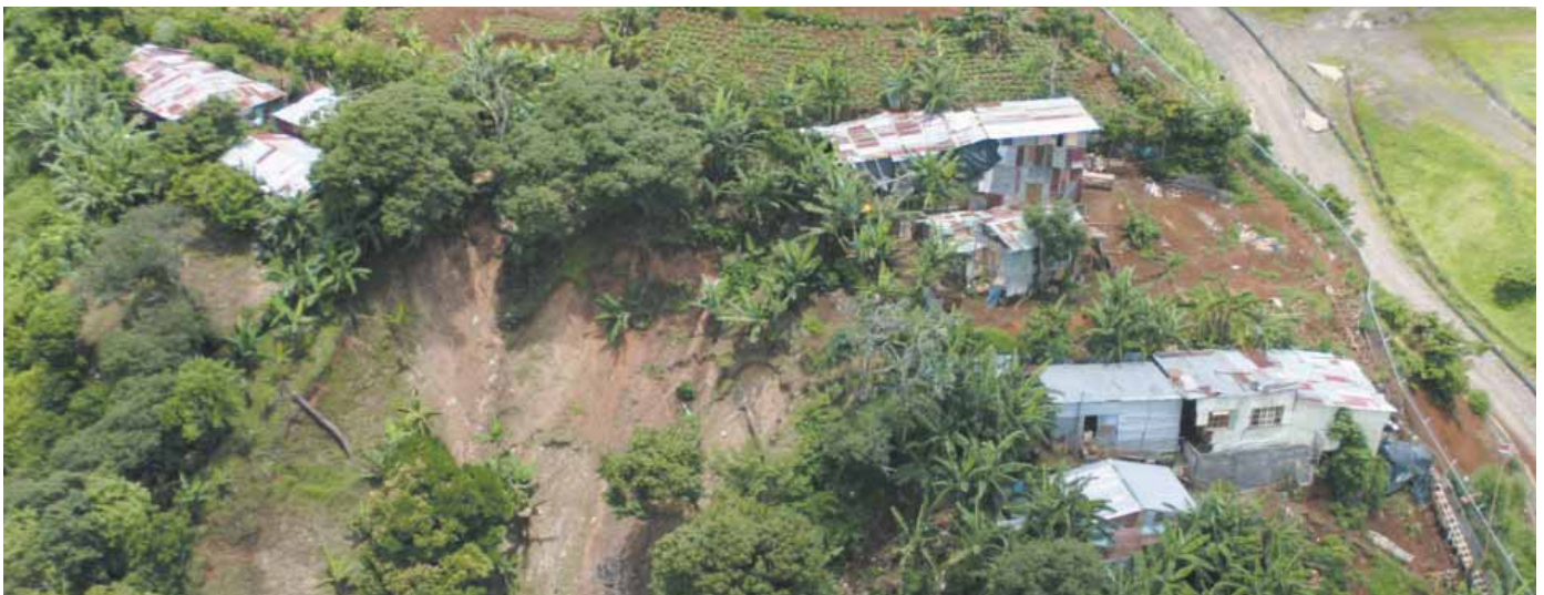
Deslizamiento de tierra en el Valle Central, Costa Rica.
