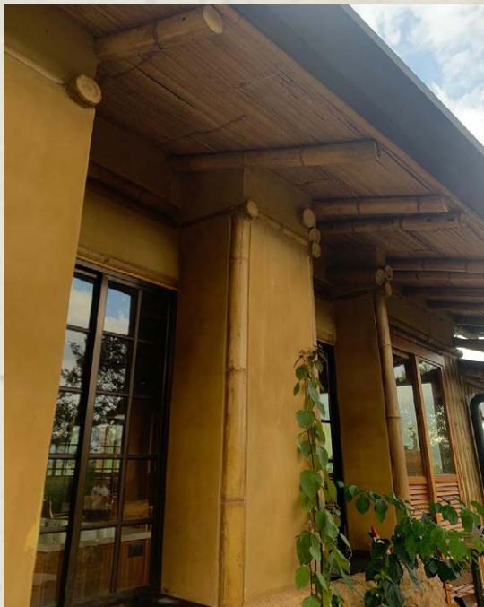
Construcción con bambú. Fotografía: PROBAMBÚ, Nataly Mendoza Hernández, 2025.
