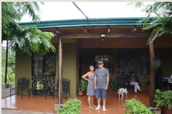
Figura 8. Vista externa de la casa CBSW.
