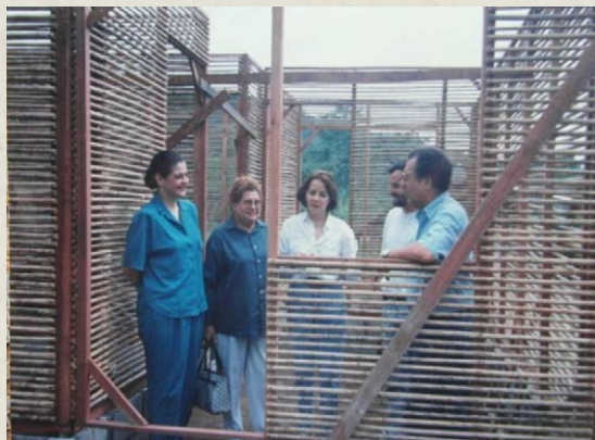
Figura 4. Variación de estructura de madera y caña brava CBSW en construcción (PNB, s. f.)
