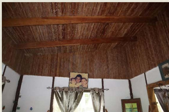
Figura 16. Vista interna de la casa CBSW: observe la madera maciza.
