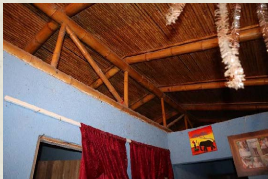
Figura 14. Vista interna de la casa CBSW: observe todo el techo de bambú.
