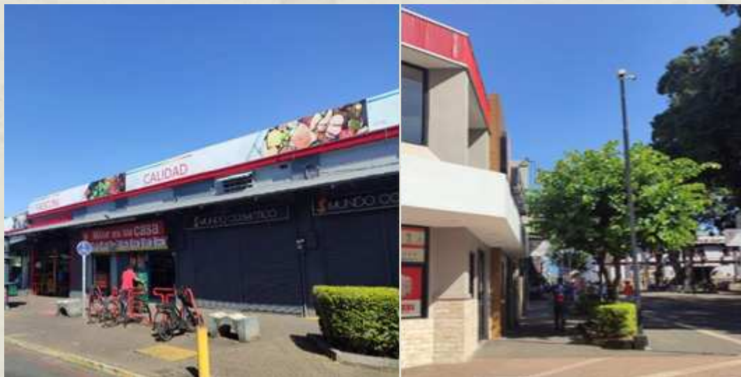
Figura 4. Ejemplos de mejoras realizadas en el centro de Alajuela: incluyen la intervención en aceras con infraestructura, arbolado y vegetación, cableado eléctrico enterrado y mobiliario urbano (estacionamiento de bicicletas, basureros, asientos).
