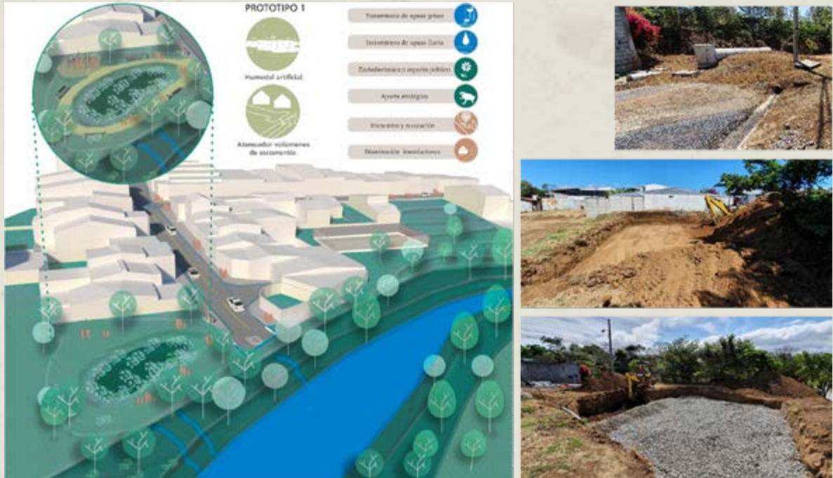
Figura 2. Ilustración del diseño de planificación de un prototipo de SbN para el tratamiento de aguas residuales y pluviales (derecha) e imágenes durante su construcción en el laboratorio del mundo real del proyecto Visión Urbana del Agua (Fuente: SEE-URBAN-WATER).
