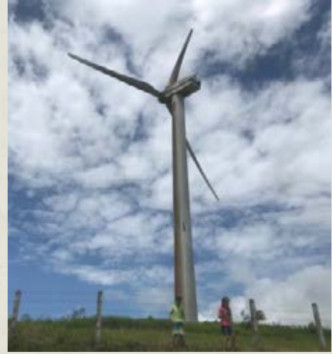
Figura 6. Parque eólico en el corredor biológico Lago Arenal Tenorio. Fotografía: Jairo Sancho.
