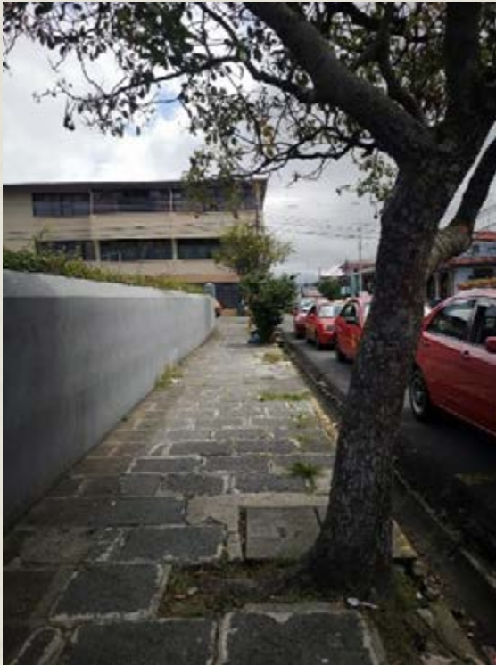
Figura 1. Árbol ubicado al costado sur de la iglesia de Tibás, cerca de una caja de registro de aguas, raíces levantan adoquines y rompen cordón del caño, además limita paso por acera. Fotografía: Ingrid Sandoval Villalobos (2019).
