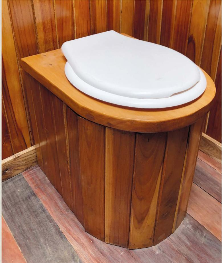
**Figura 9.** Este inodoro seco de compostaje ubicado en una institución local tiene alta aceptación.
