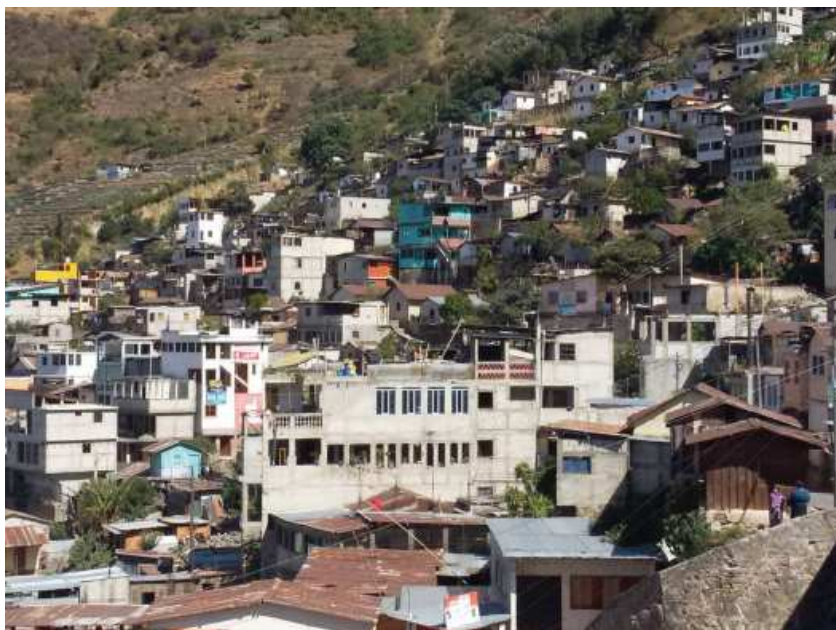
Planificación inadecuada incrementa el riesgo de las ciudades. Fotografía: Sergio Molina-Murillo.
