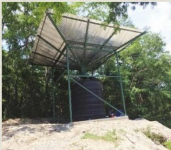
**Figura 6.** Tanque para la cosecha de agua (21 000 litros) instalado en sector Catalinas para la atención de incendios y proveer del líquido a la biodiversidad en época seca. Fotografía: Wilfran Murillo.
