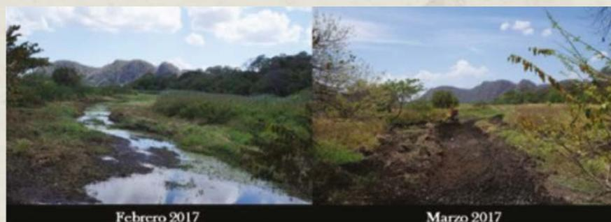
**Figura 3.** Recaba de sedimentos y limpieza de maleza en quebrada La Mula para devolverle la estacionalidad y con ello evitar la inundación permanente con agua procedente Distrito de Riego Arenal Tempisque. Fotografías: Lenin Corrales.
