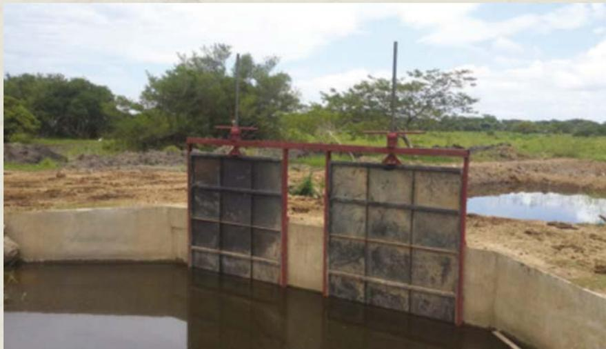
**Figura 4.** Compuerta reconstruida, modificada y colocada en el drenaje El Charco para el manejo de las aguas procedentes de las mareas. Fotografía: J. Leal (2016)
