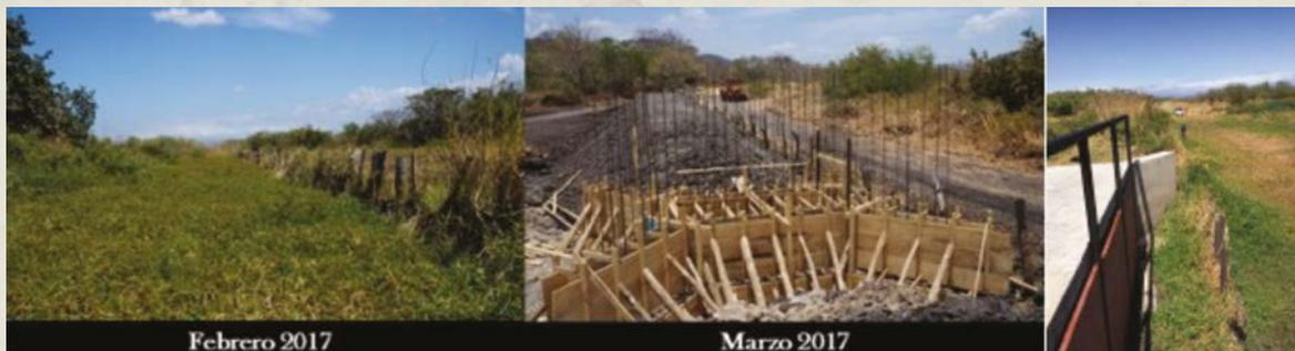
**Figura 4.** Sistema de compuertas para el manejo y regulación de flujos hídricos naturales y artificiales. Fotografías: Lenin Corrales y Wilfran Murillo.
