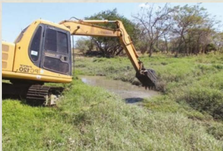
**Figura 3.** Maquinaria en proceso de extracción de sedimentos y malezas en el sector del canal principal del humedal Mata Redonda, HPII Palo Verde. Fotografía: J. Leal (2017).
