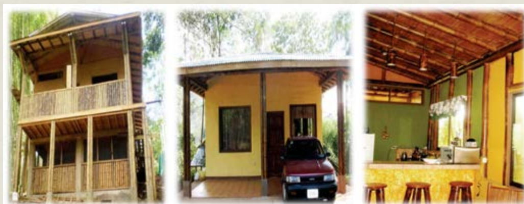
Figura 6. Casas construidas en Pérez Zeledón utilizando bambú
