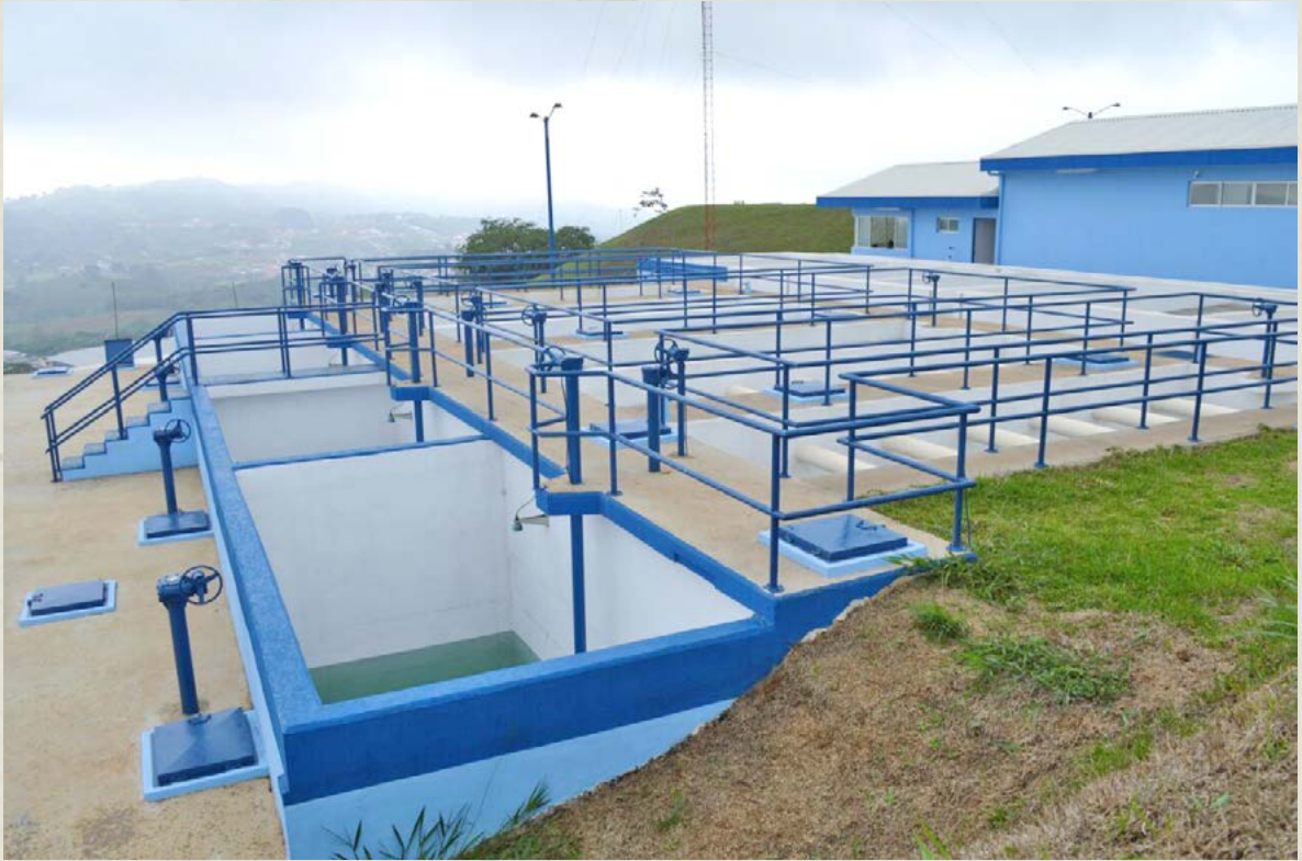
AyA. Planta de Tratamiento de agua Potable San Ramón, Costa Rica.
