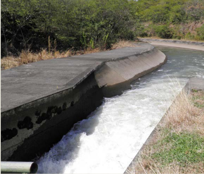
Sergio Molina. Canales de conducción en Distrito de Riego Arenal-Tempisque, SENARA.
