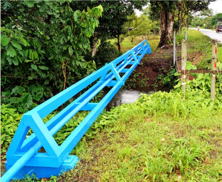
AyA. Acueducto ASADA Guatuso, Costa Rica.
