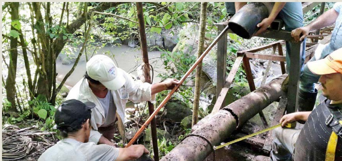
AyA. Proyectos de abastecimiento y construcción.
