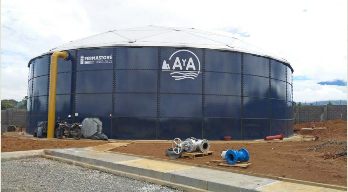
AyA. Tanque de agua, Buenos Aires, Costa Rica.
