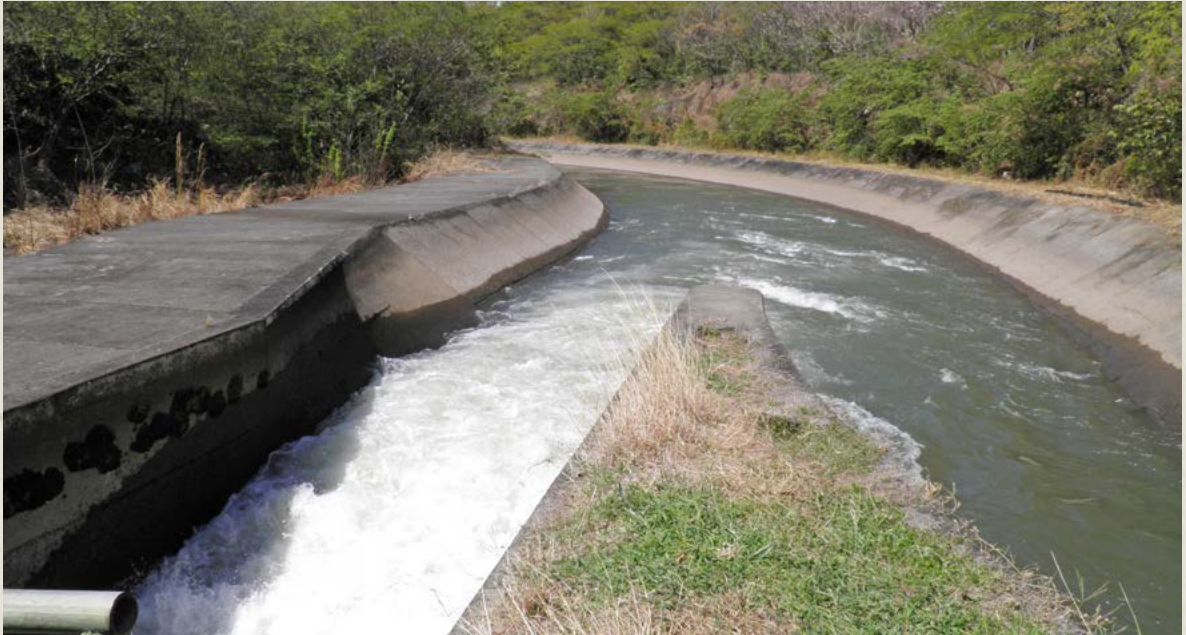
Sergio Molina. Canales de conducción en Distrito de Riego Arenal-Tempisque, SENARA.
