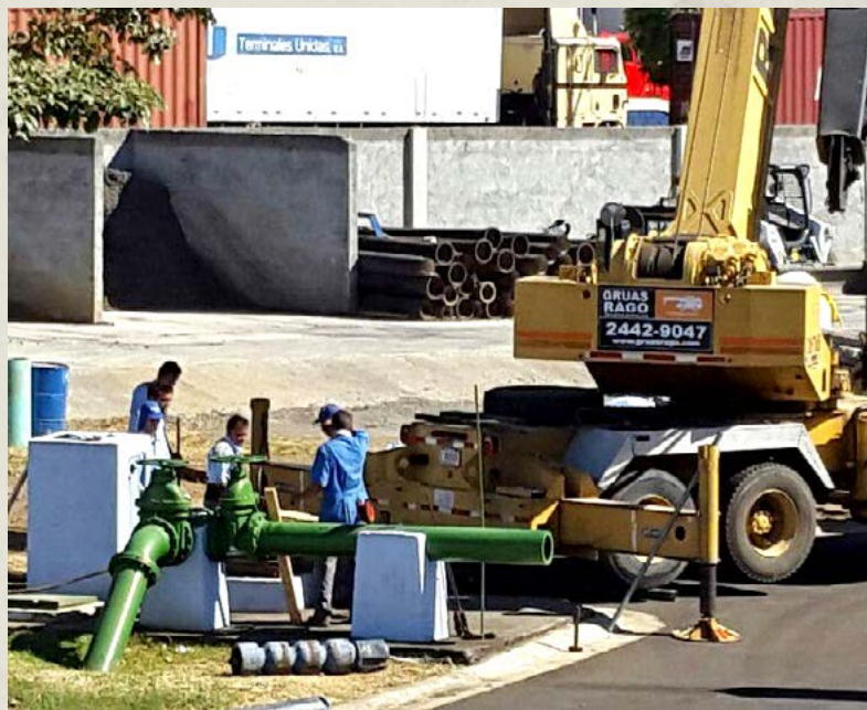
AyA. Proyectos de abastecimiento y construcción.
