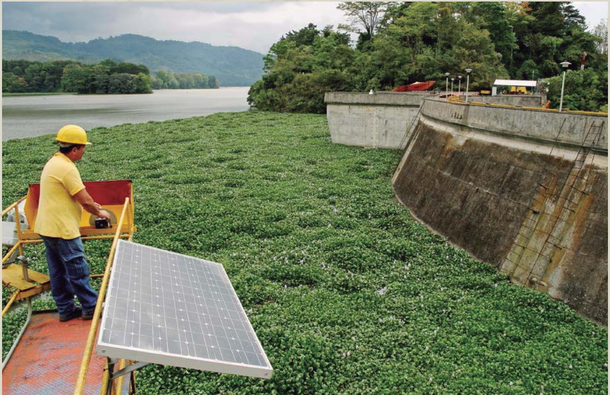
Alfredo Huerta. Represa hidroeléctrica Cachí, Costa Rica.
