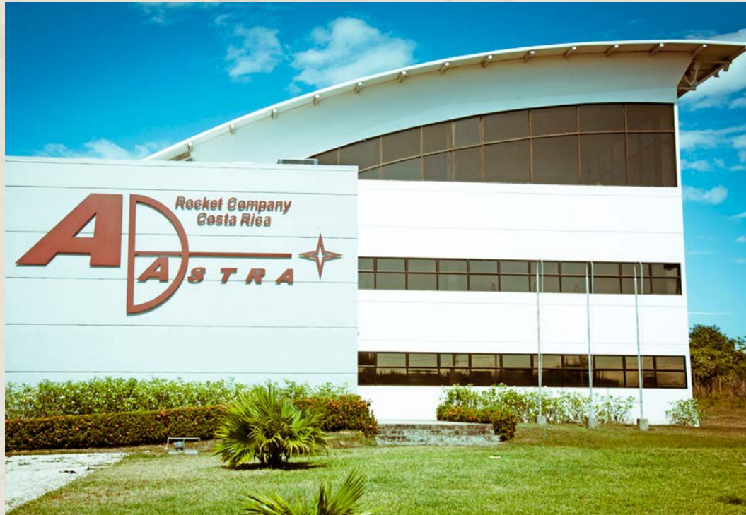
Mariela Víquez. Instalaciones de Ad astra, Guanacaste, Costa Rica.
