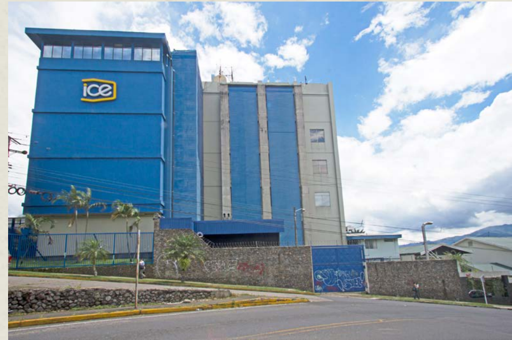
A. Baltodano. Oficinas del Instituto Costarricense de Electricidad, San Pedro, San José.
