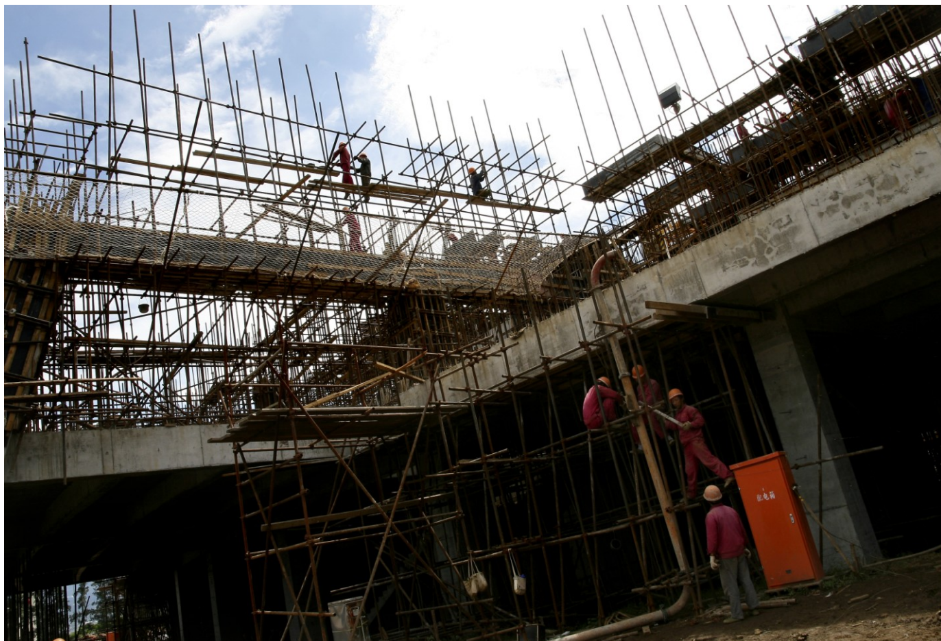
Construcción Estadio Nacional
