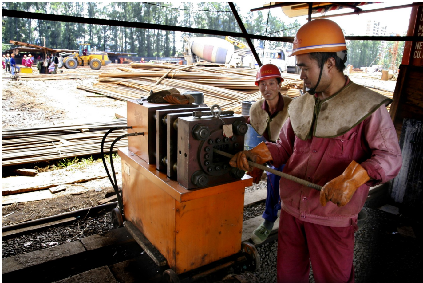
Construcción Estadio Nacional
