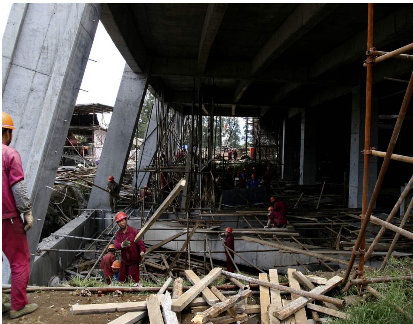
Construcción Estadio Nacional
