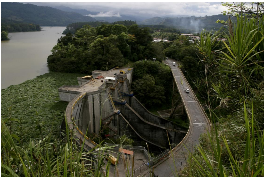
Planta Hidroeléctrica Cachi
