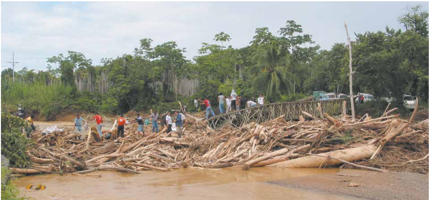
Destrucción por crecida de río en Pacífico sur, Costa Rica
