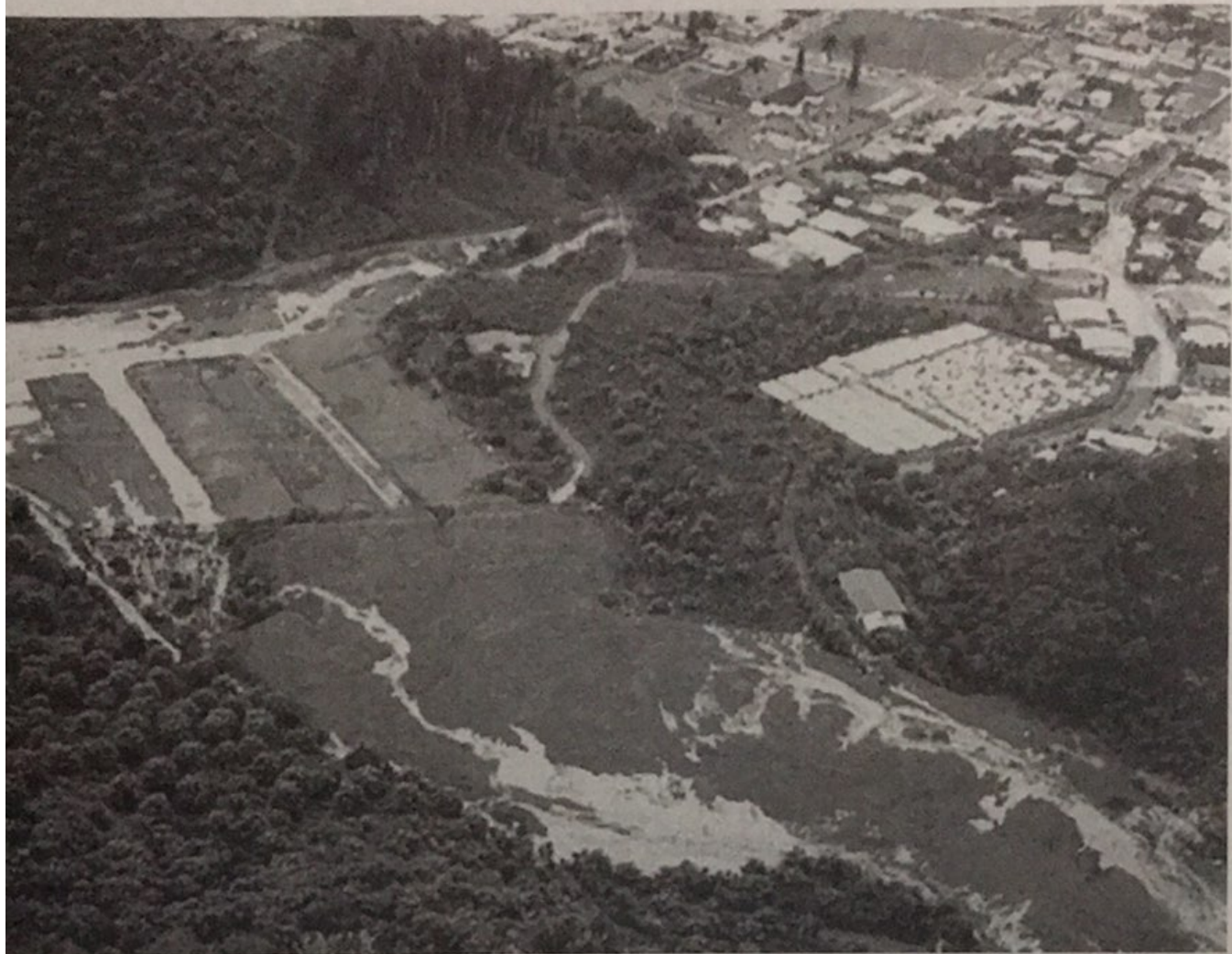
Deslizamiento sobre Alto Loaliza
